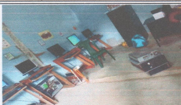
Foto 2: En la foto se observa el cambio de piso ceramico para laboratorio de Computación y Dirección.
