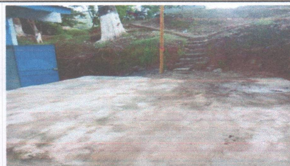
Foto 4: Se observa el cambio de gradas con su estructura de agarre tubos de metal para los alumnos
