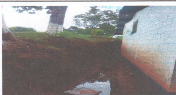
Foto 3: Se observa la colocacion de canales de lluvia
