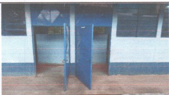
Foto 5: Se observa el cambio de puertas y chapas
